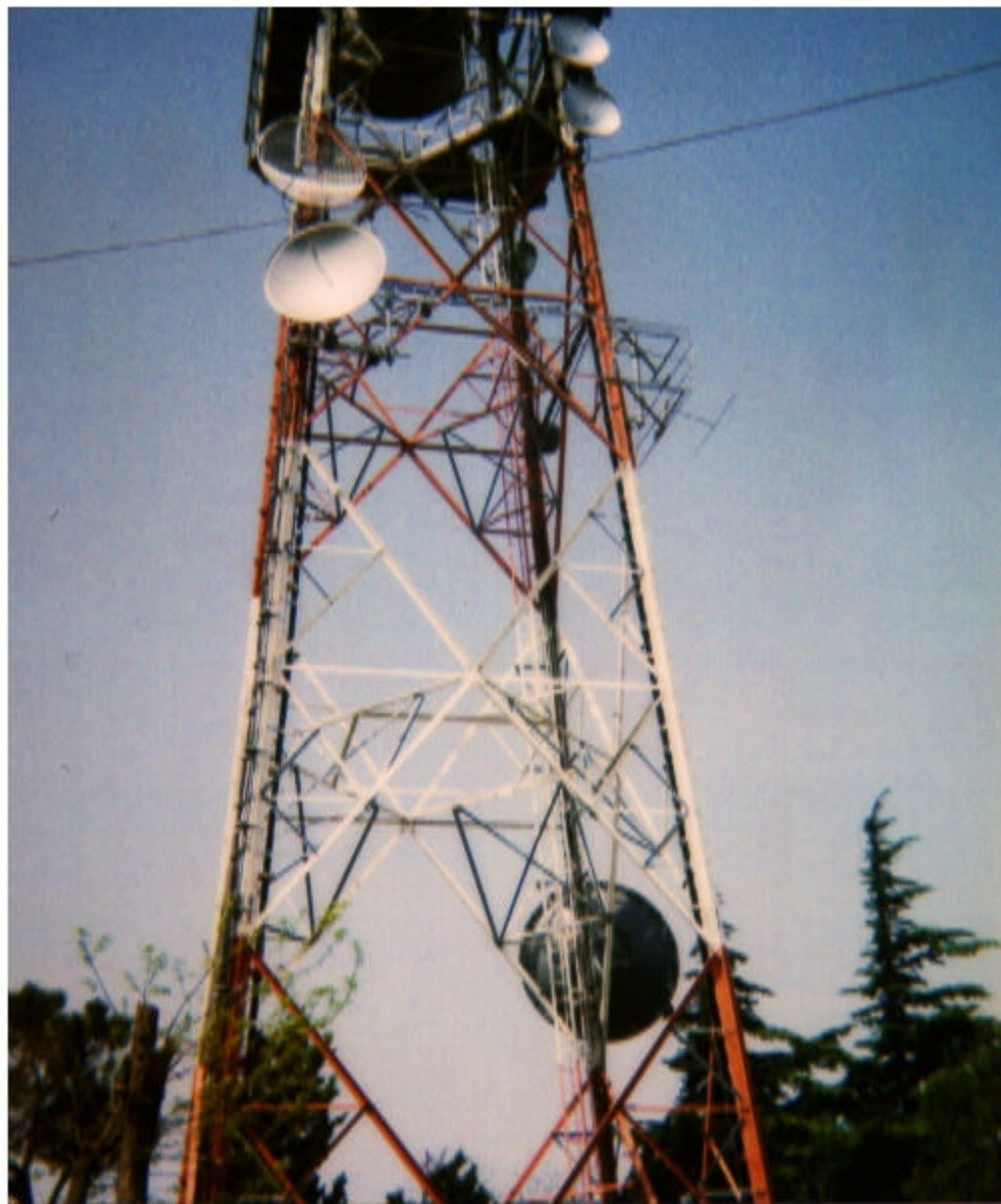
Vista da Est, dopo l'installazione
