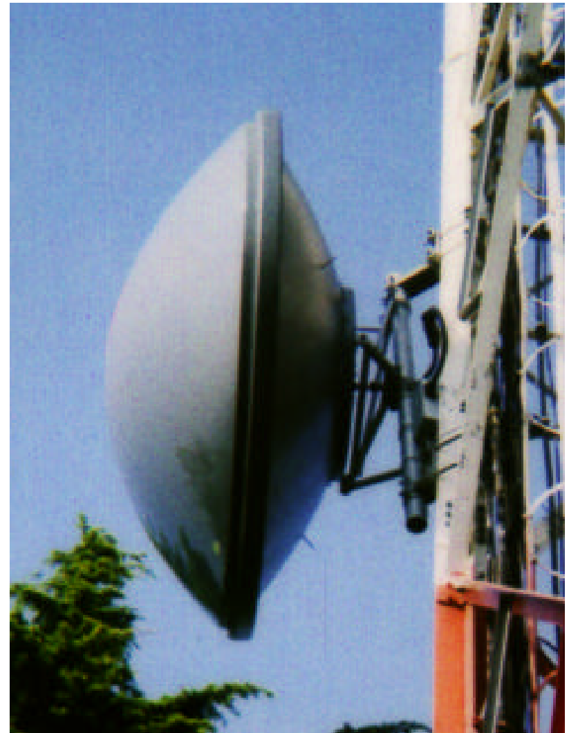
Vista da lato
